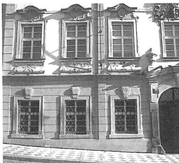
Obr. 6. a 7. Aplikaci vnitřně hydrofobizovaných omítek dochází k poškození i dalších prvků fasády, které jsou zhotoveny z nasákavého materiálu – zde např. kamenných ostění pod tenkou vrstvou omítky. Na ostěních je omítko tmavší – je tedy zavlhlá. Po čase se objevily výkvěty solí, odlupování tenké vrstvy omítky a destrukce kamene.
