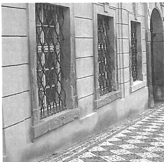
Obr. 6. a 7. Aplikaci vnitřně hydrofobizovaných omítek dochází k poškození i dalších prvků fasády, které jsou zhotoveny z nasákavého materiálu – zde např. kamenných ostění pod tenkou vrstvou omítky. Na ostěních je omítko tmavší – je tedy zavlhlá. Po čase se objevily výkvěty solí, odlupování tenké vrstvy omítky a destrukce kamene.
