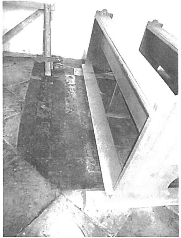
Obr. 8. a 9. Příklad poruchy, kde byly vnitřně hydrofobizované omítky naneseny z exteriéru i interiéru neizolované stavby. Obrázky ukazují, jak vztlínající vlhkost nadměrně zatěžuje původní nasávkavou cihelnou podlahu. Tam, kde jsou na podlaze cihly, dochází k růstu biofilmu. V ohrožení je tak i dřevěný mobiliář, který od nadměrně vlhké podlahy navlhá a rychle se poškozuje.
