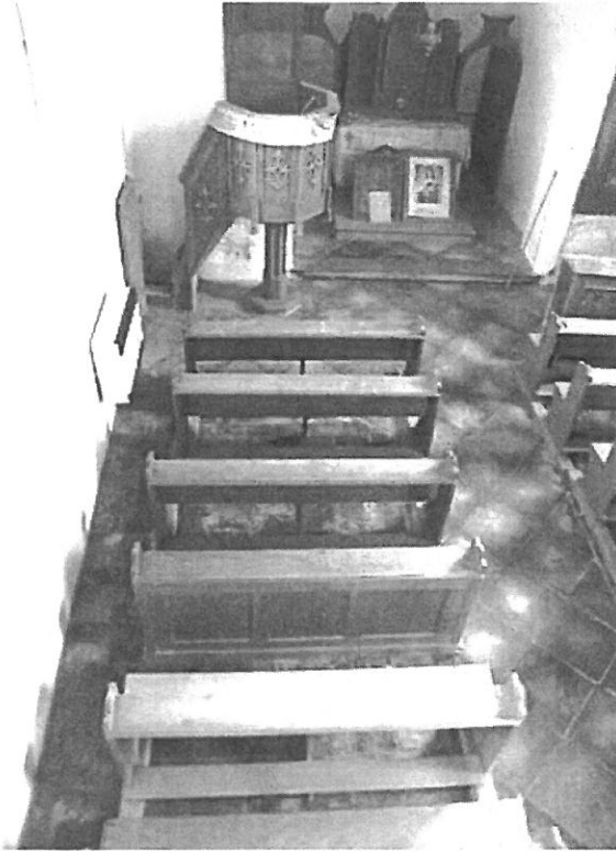
Obr. 8. a 9. Příklad poruchy, kde byly vnitřně hydrofobizované omítky naneseny z exteriéru i interiéru neizolované stavby. Obrázky ukazují, jak vztlínající vlhkost nadměrně zatěžuje původní nasávkavou cihelnou podlahu. Tam, kde jsou na podlaze cihly, dochází k růstu biofilmu. V ohrožení je tak i dřevěný mobiliář, který od nadměrně vlhké podlahy navlhá a rychle se poškozuje.
