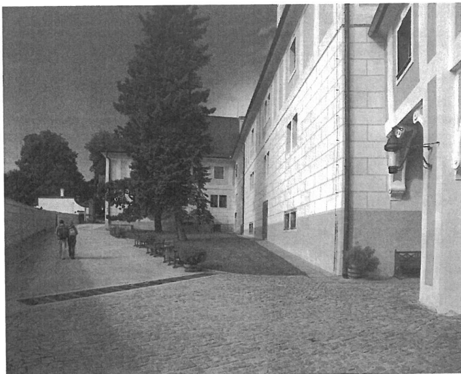
Obr. 13. Objekt byl opatřen novými dešťovými svody se zaústěním do kanalizace. Vně obvodových stěn byl vybudován široký provzdušňovací kanál se zajištěním samotížné cirkulace vzduchu výškovým rozdílem vstupních a výstupních otvorů na fasádě. Styk terénu s fasádou byl chráněn proti vodě krytem ze širokých kamenných desek. S odstupem několika let byla provedena podobná úprava i v dispozici objektu (provzdušňový prostor pod podlahou v celém půdorysu). Zároveň bylo zajištěno větrání interiérů divadla v souladu s původním konceptem stavby. Stavební úpravy byly provedeny v 80. letech 20. století. Přestože účinek takto koncipované konsolidace stavební podstaty není v těchto případech nikdy okamžitý, vždy splní daný účel. S odstupem cca 40 let od provedených úprav není sebemenších pochyb, že bylo zvoleno řešení efektivní, šetřivé, dlouhodobě účinné (zámecké barokní divadlo v Českém Krumlově, současný stav 2019).
