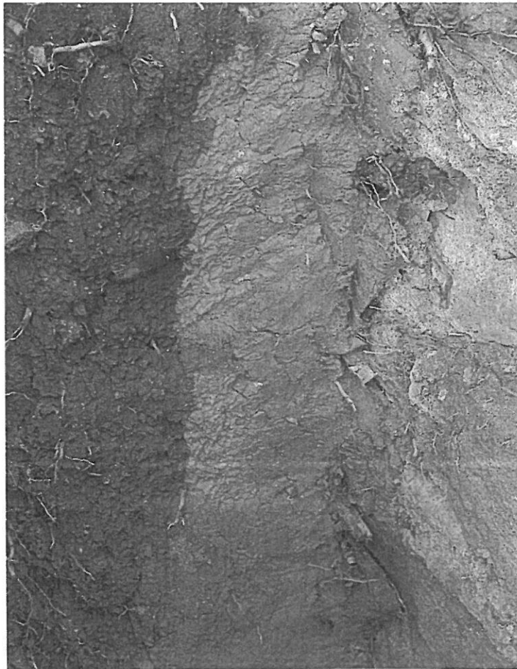
Obr. 2.: Při výkopu sondy při patě zdiva nebylo pozorovatelům nic nápadného až do chvíle, kdy začalo pršet a kdy se viditelně odhalilo rozhraní mezi suchou jílovou izolací a promáčenou zemínou – na snímku viz Plzák španělský, lat. Arion vulgaris (usedlost Kotlářka v Praze, 1999).
