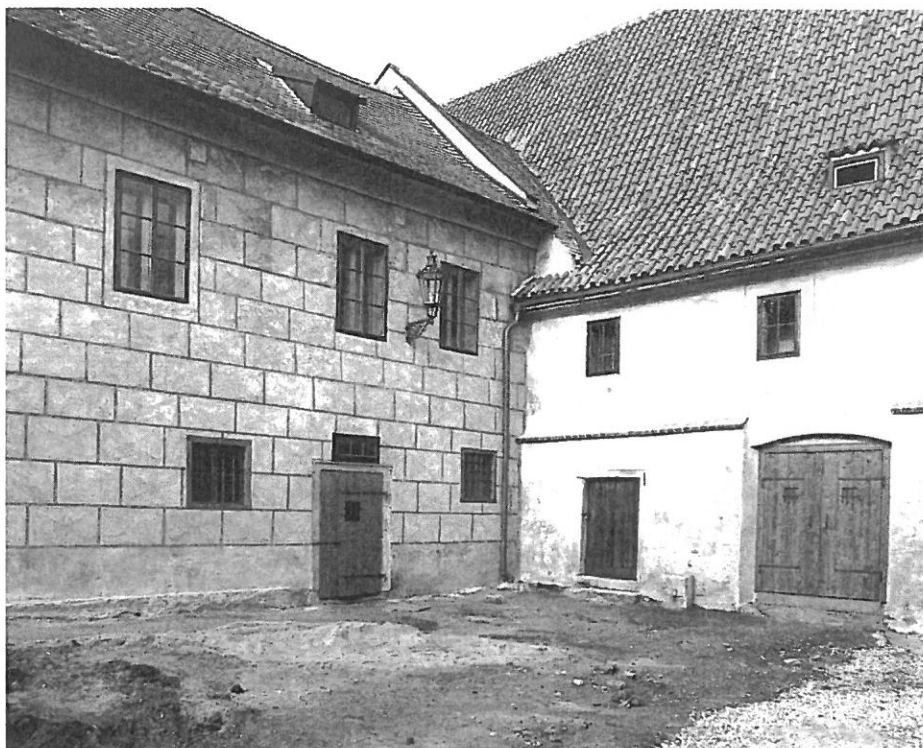
Obr. 5.: Po odstranění příčin poruch byla v tradiční vápenné technologii restaurátorsky obnovena původní renesanční úprava fasády s plochou rustikou (objekt renesančního pivovaru v areálu českokrumlovského zámku, 2008).
