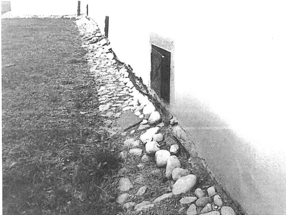
Obr. 11.: Ukázka zcela absurdní úpravy, velmi rozšířené v posledních letech, která nejenže nezabrání pronikání vlhkosti do zdiva, ale mnohdy naopak zhorší kondici historické konstrukce. Nopová fólie přiložená na líc zdiva, či obdobné materiály v žádném případě neumožňují cirkulaci vzduchu. Nezakrytý štěrkový zásyp výkopu, byť doplněný u paty základů drenáží (jejíž funkci navíc nelze zkontrolovat), je technicky zcela nelogickým opatřením, v jehož důsledku dochází nezřídka paradoxně k zavodnění základů stavby, navíc s vyplýtváním značných finančních prostředků. (ilustrace převzata z: Pavol Ižvolt, Údržba historických stavieb, príručka pre preventívnu údržbu nehnuteľných pamiatok – skúsenosti z projektu Pro Monumenta, Pamiatkový úrad Slovenskej republiky, Bratislava 2017).
