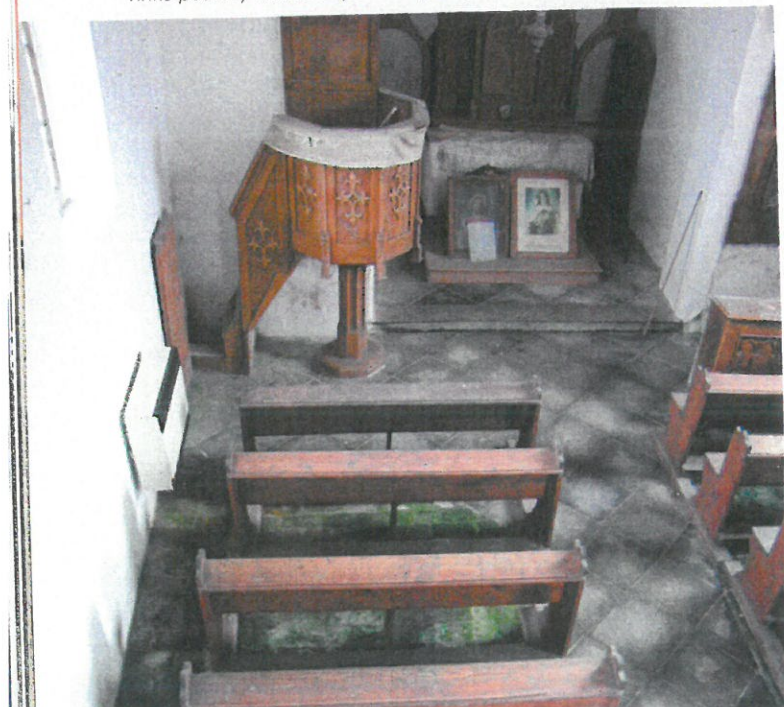
▼ Obr. 7 a 8 Jiný příklad poruchy, kde byly vnitřně hydrofobizované omítky nanášeny z exteriéru i interiéru neizolované stavby. Obrázky ukazují, jak vztlínající vlhkost nadměrně zatěžuje původní nasákavou cihelnou podlahu, na snímku pod vrstvou biofilmu. V ohrožení je i dřevěný mobiliář, který od nadměrně vlhké podlahy navlhá a rychle degraduje.
