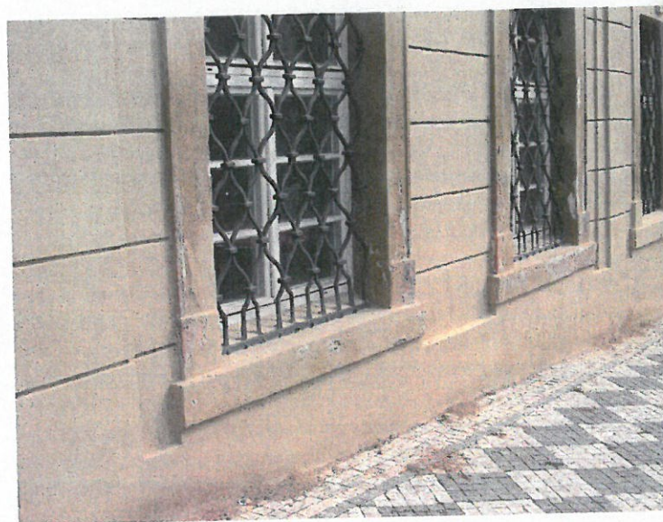
▲ Obr. 5 a 6 Příklad, kdy aplikaci vnitřně hydrofobizovaných omítek dochází k poškození těch prvků fasády, které jsou zhotoveny z nasákavého materiálu – v tomto případě např. kamenných ostění pod tenkou vrstvou omítky. Na ostěních je omítka tmavší, tedy zavlhlá. Po čase se objevily výkvěty solí, odlupování tenké vrstvy omítky a drobení kamene.
