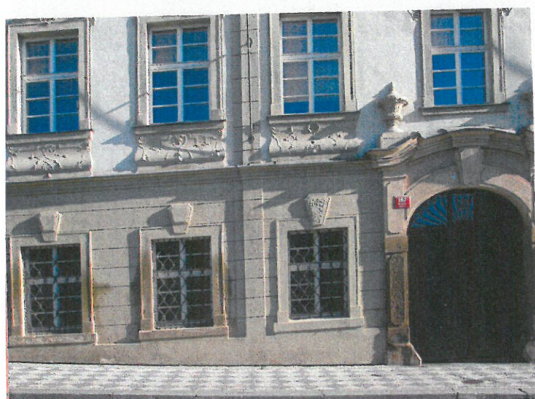
▲ Obr. 5 a 6 Příklad, kdy aplikaci vnitřně hydrofobizovaných omítek dochází k poškození těch prvků fasády, které jsou zhotoveny z nasákavého materiálu – v tomto případě např. kamenných ostění pod tenkou vrstvou omítky. Na ostěních je omítka tmavší, tedy zavlhlá. Po čase se objevily výkvěty solí, odlupování tenké vrstvy omítky a drobení kamene.
