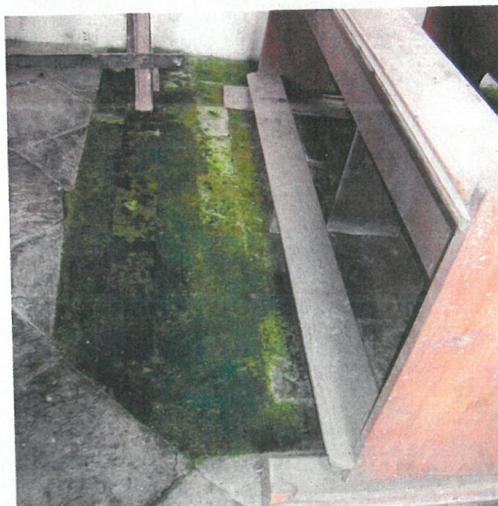
▼ Obr. 7 a 8 Jiný příklad poruchy, kde byly vnitřně hydrofobizované omítky nanášeny z exteriéru i interiéru neizolované stavby. Obrázky ukazují, jak vztlínající vlhkost nadměrně zatěžuje původní nasákavou cihelnou podlahu, na snímku pod vrstvou biofilmu. V ohrožení je i dřevěný mobiliář, který od nadměrně vlhké podlahy navlhá a rychle degraduje.
