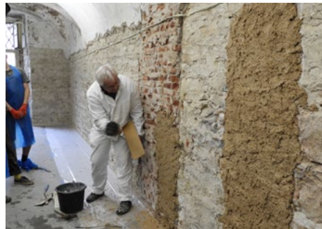
↑ Kurz práce s vápnem v Invalidovně v Praze. Postup nahazování odsolovací omítky předvádí profesor Václav Girs
