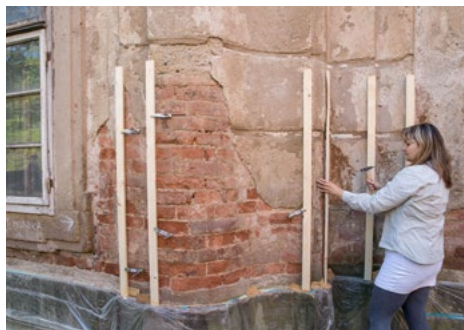
↑ Doplnění plastických bos při letní škole práce s vápnem pro pokročilé studenty v Plasích
