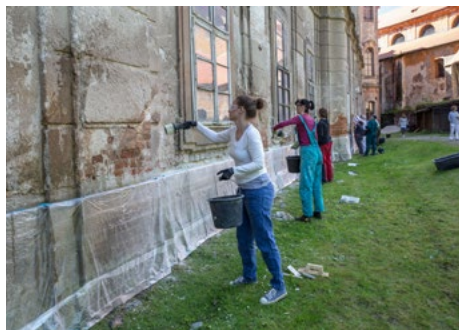
↑ Vlhčení podkladu před nanášením odsolovacích omítek v rámci letní školy práce s vápnem v Plasích
