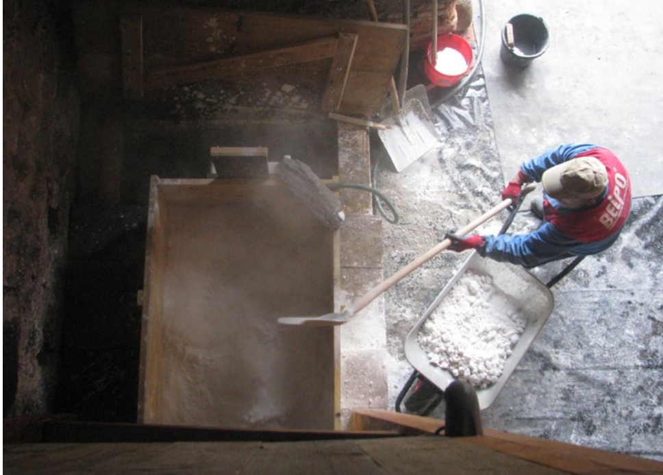
↑ Plnění hasnice nehašeným vápnem při experimentálním hašení vápna na SH Švihov
